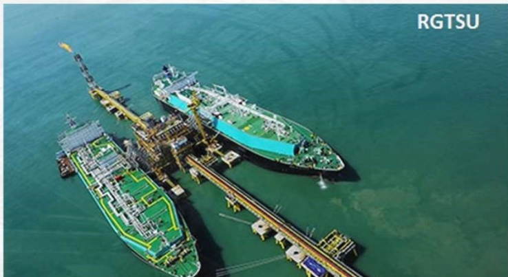
LNG Reloading Facility
